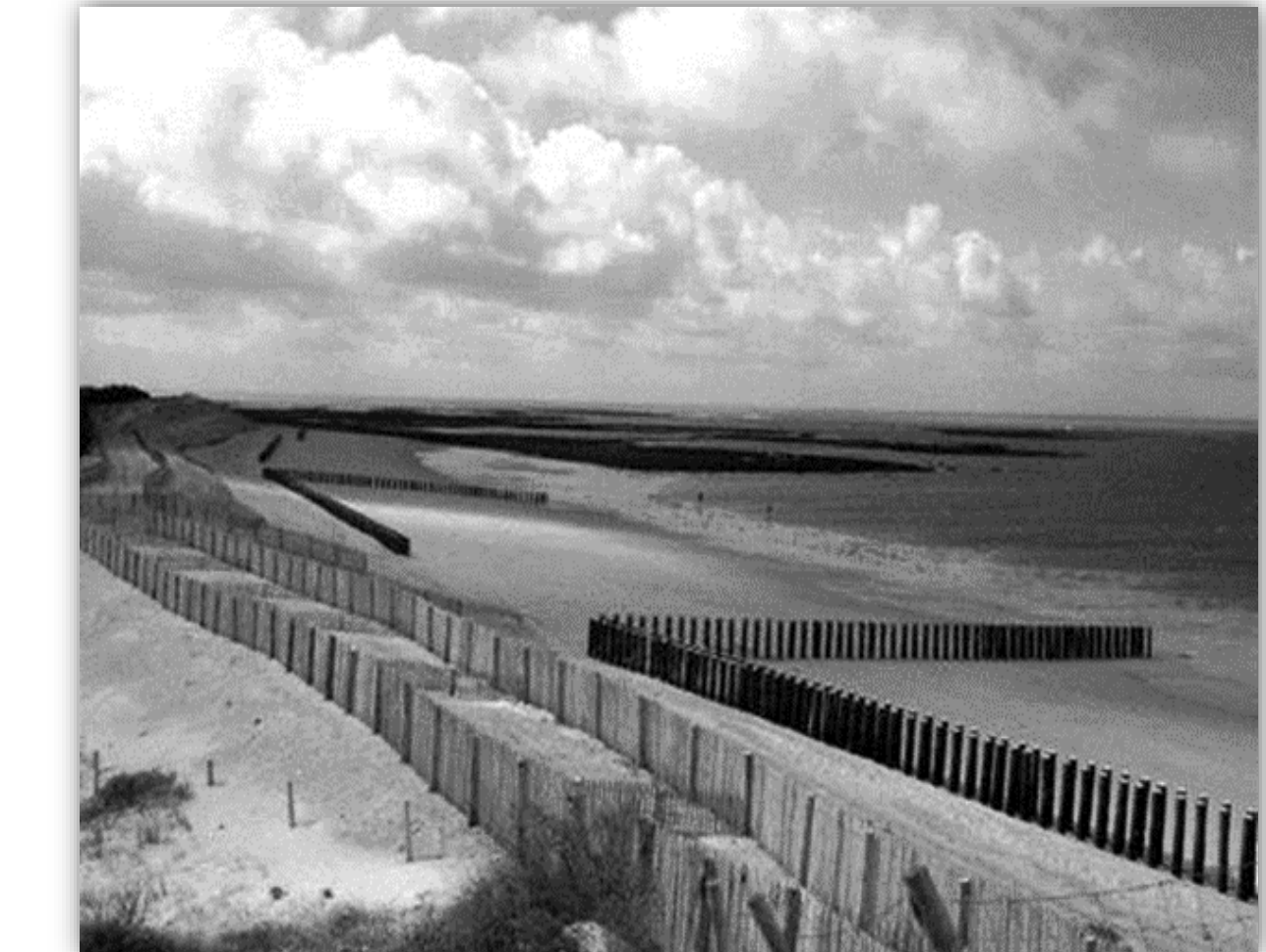
Pieux hydrauliques en équerre et ganivelles en haut de dune à Noirmoutier (Fatal et al., 2010)
