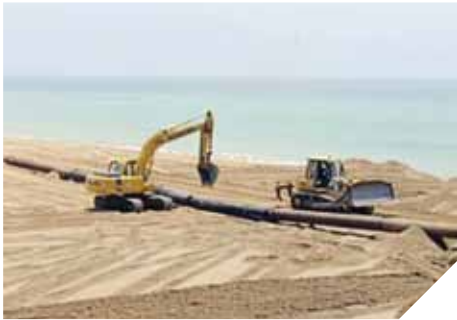
Forte Novo – rechargement de l'estran Garrão, 2010 (Portugal)
