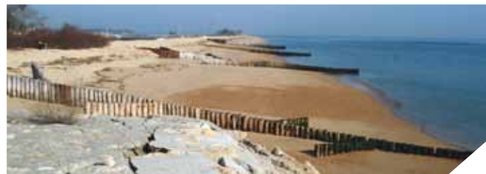
Pieux hydrauliques transversaux, Mimbeau, Cap Ferret, Aquitaine (France)
