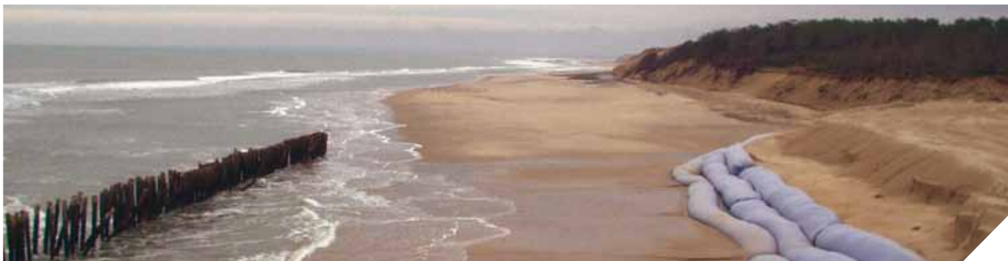
Ouvrages en géotextiles (France)
