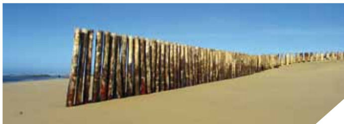
Pieux hydrauliques transversaux, Cap Ferret, Aquitaine (France)
