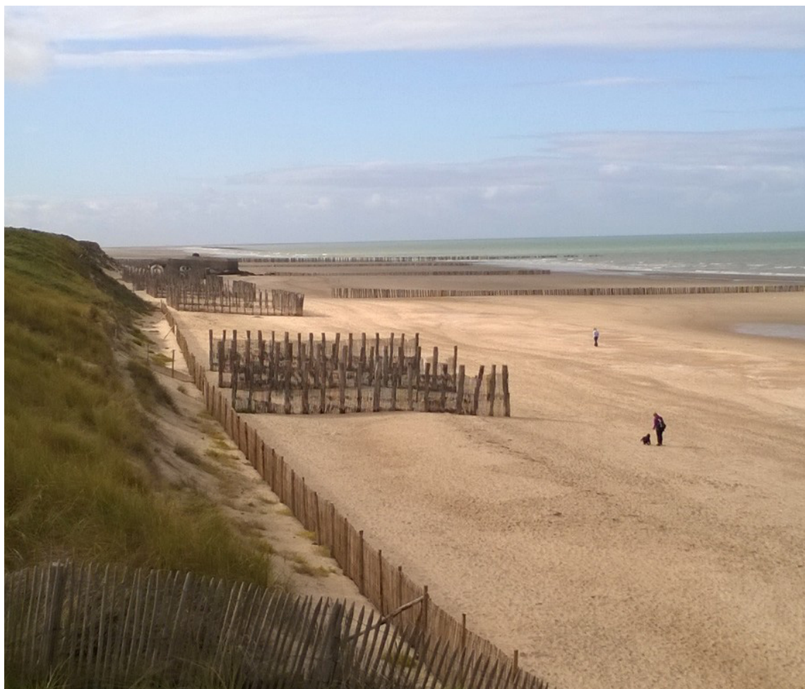
Face au lotissement des Ecardines, des épis, des casiers à vent et des ganivelles sont installés à titre expérimental depuis de nombreuses années, mais chaque tempête laisse des traces.
