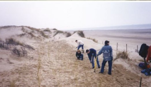
1999 - Intervention pour limiter l'érosion
