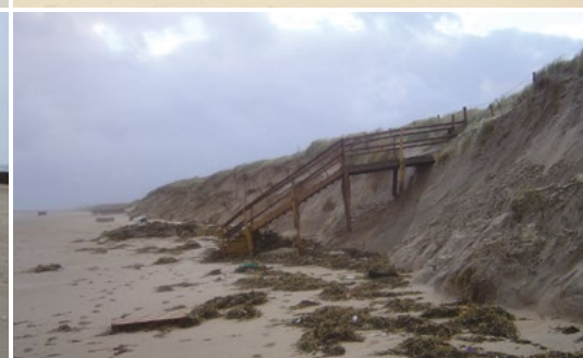
Mars 2007 - forte érosion
